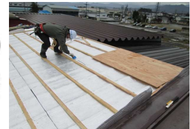
図1-2. 施工風景(カバー工法)
